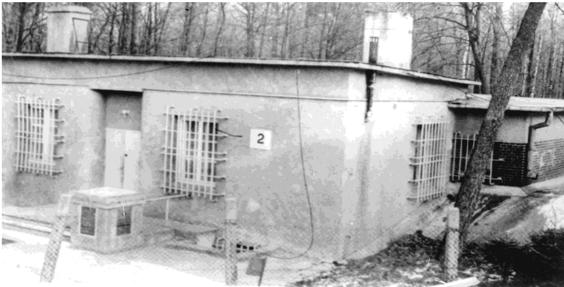
fot. 24. Budynek Biura Szyfrów - siedziba Wydziału BS4 w lasach kabackich /Piry/, w którym polscy kryptolodzy 24-26 lipca 1939r. przekazali Anglikom i Francuzom zbudowaną przez Polaków replikę ENIGM
